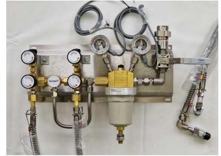
Zentraler Teil der Atemluftversorgung ab Flaschen ist die Entspannungsstation. Sie reduziert den Druck der Druckluftflaschen, die auch als komplettes Flaschenbündel vorliegen können, von bis zu 300 bar auf 0 ... 16 bar. Zu Überwachung und Signalisierung von Vor- und Hinterdruck verfügt die Entspannungsstation über Kontaktmanometer, deren Schalterpunkt individuell gewählt werden können.
